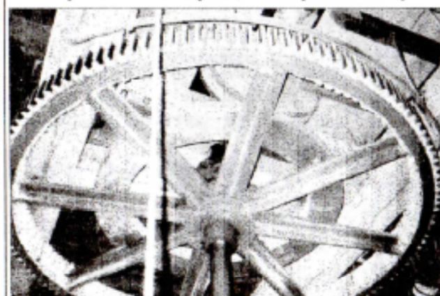
Metalen drijfwerk met houten kammen en staven te zien in de Aalstermolen te Waalre.
