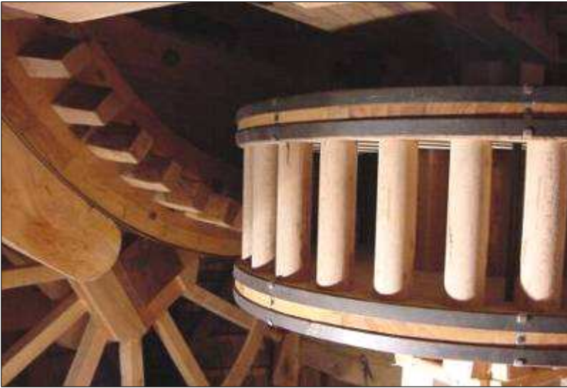
rondsel van een binnenkruier
