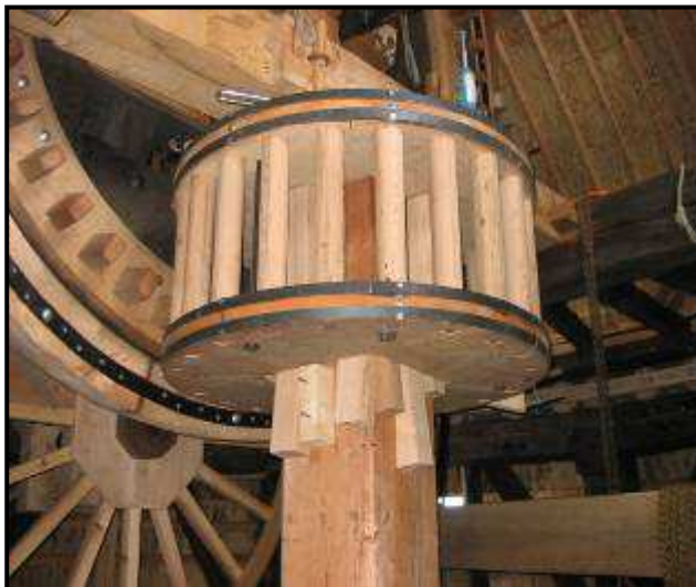
schijfloop in opbouw (afgebrande molen C )
