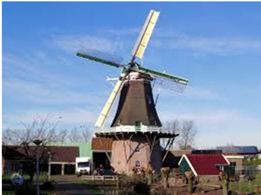
Molen 3. De Hoop in Stiens. Van Bussel, Ten Have en Fael wiekstystemen. Instructiemolen en zeilmakerij. In 1993 hypermoderne computergestuurde molen met o.a. elektrisch luiwerk, centrale stofazuiging, meel-elevator etc. tot 2002. Nu weer in de juiste staat: op windkracht. Molenzeilmakerij Koning heeft er zijn werkplaats.
